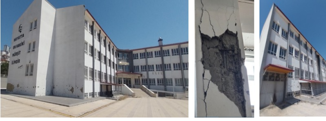
Şekil 15: Okul Binası 7 (Güçlendirilmemiş)
