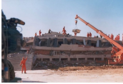
Şekil 5: Çeltiksuyu YİBO a) Yurt binası, b) Eğitim binasına ait enkaz görüntüsü. Figure 5: Destruction of the a) dormitory building, b) academic building of Çeltiksuyu Regional Boarding School
