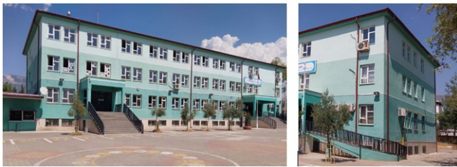
Şekil 9: Okul Binası 1 (Deprem öncesi güçlendirilmiş) Figure 9: School Building 1 (Reinforced before the earthquake)
