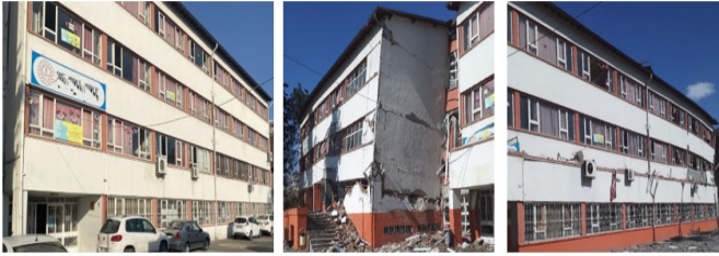
Şekil 17: Okul Binası 9 (Güçlendirilmemiş)
