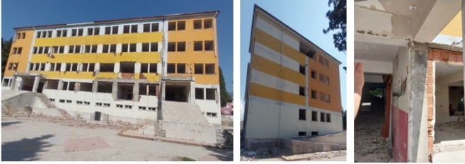
Şekil 16: Okul Binası 8 (Güçlendirilmemiş)
