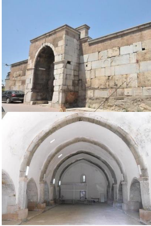
Görsel 4. ve Görsel 5. Raziye Sultan Kervansarayı iç ve dış görünüşü
