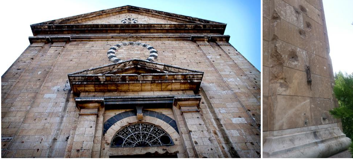
Şekil 17. Kilise doğu cephesinde şarapnel izleri
