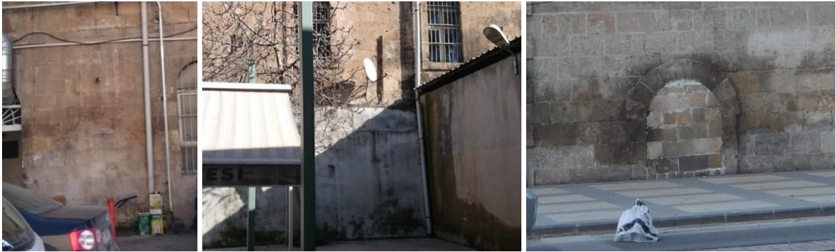
Şekil 14. Okul kuzey, doğu ve güney cephelerinde renk değişimi
