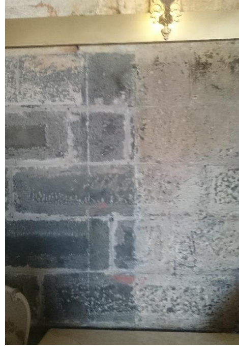
Şekil 18. Sera etkisi sonucunda ortaya çıkan bitki oluşumu, kilise kriptada bazalt duvarda renk değişimi
