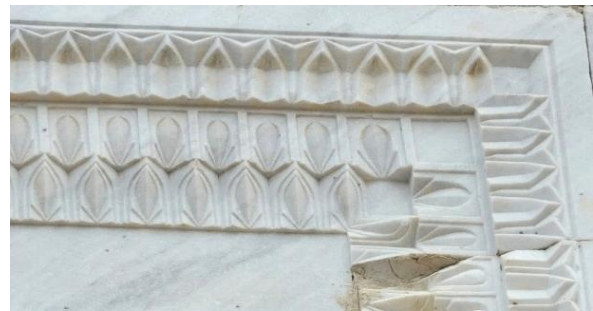
Şekil 84: İlyas Bey Camii'nin Batı Cephesindeki Mukarnas Pervazlı Pencerenin Detaylı Görünümü.
