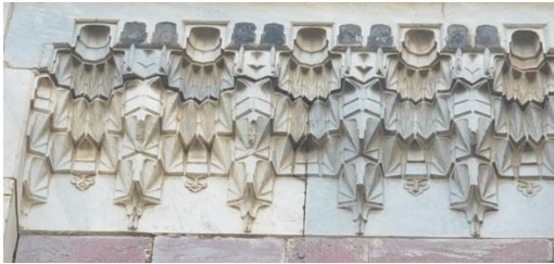
Şekil 37: Firuz Bey Camii'nden Bir Pencere Üzerindeki Mukarnas Frizi.
