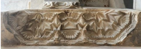
Şekil 68: İlyas Bey Camii'nin Cümle Kapısının Sol Taraftaki Çifte Kemerin Konsol Mukarnasının Alt Görünümü
