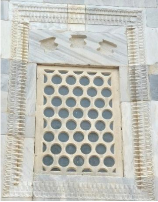
Şekil 83: İlyas Bey Camii'nin Batı Cephesindeki Mukarnas Pervazlı Pencerenin Genel Görünümü.
