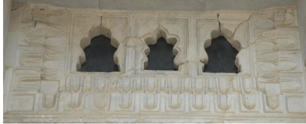
Şekil 78: İlyas Bey Camii'nin Giriş Kapı Üstündeki Mukarnaslı Pencere Pervazının Detayları
