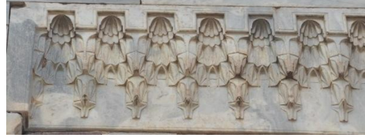
Şekil 33: Firuz Bey Camii'nden Bir Pencere Üzerindeki Mukarnas Frizi.
