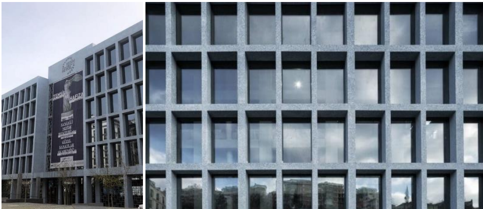
Şekil 6. İRHM Giriş Cephesi ve Cephe Izgarası (Bilgiç, 2019)
