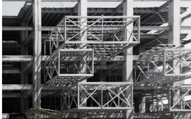
Şekil 8. İRHM taşıyıcı sistem ve galerilerin inşa aşaması (Arkitektuel, n.d.)
