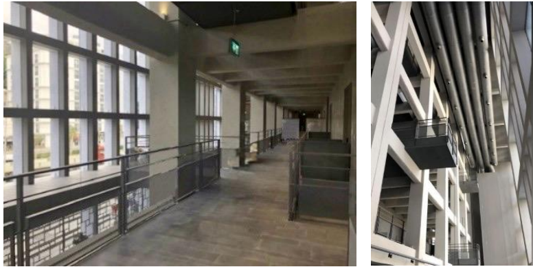
Şekil 10. İçine sergi alanları yerleşen betonarme ızgara, ızgara ile cepheyi ayıran galeri boşluğu (Bilgiç, 2019)
