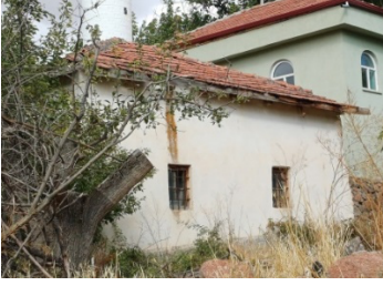
Görsel 13. Güney cephe.
