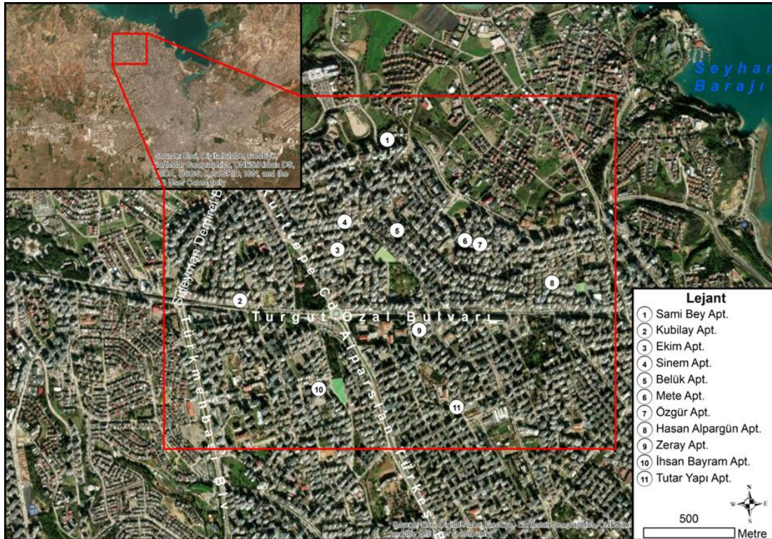
Şekil 1. Adana'da Kahramanmaraş Depremlerinde Yıkılan Binaların Mekânsal Dağılışı (Çağatay vd., 2023'ten düzeltilerek hazırlanmıştır).
