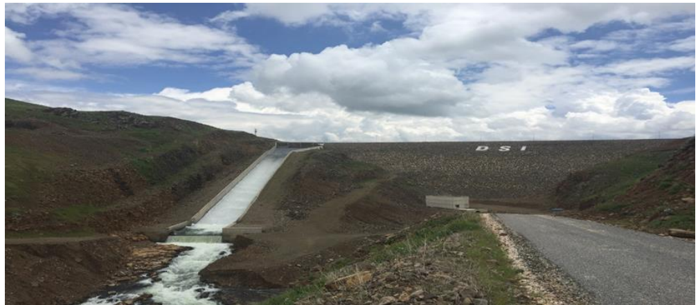
Şekil 1. Morgedik Barajı (Mansapta Görünüm) (DSİ, 2016).
