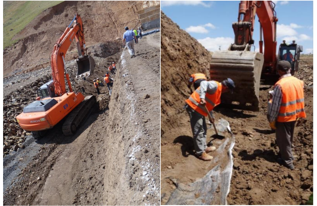
Şekil 12. Makine ve işçiler tarafından yapılan kazılar (GEOPLAS, 2014)
