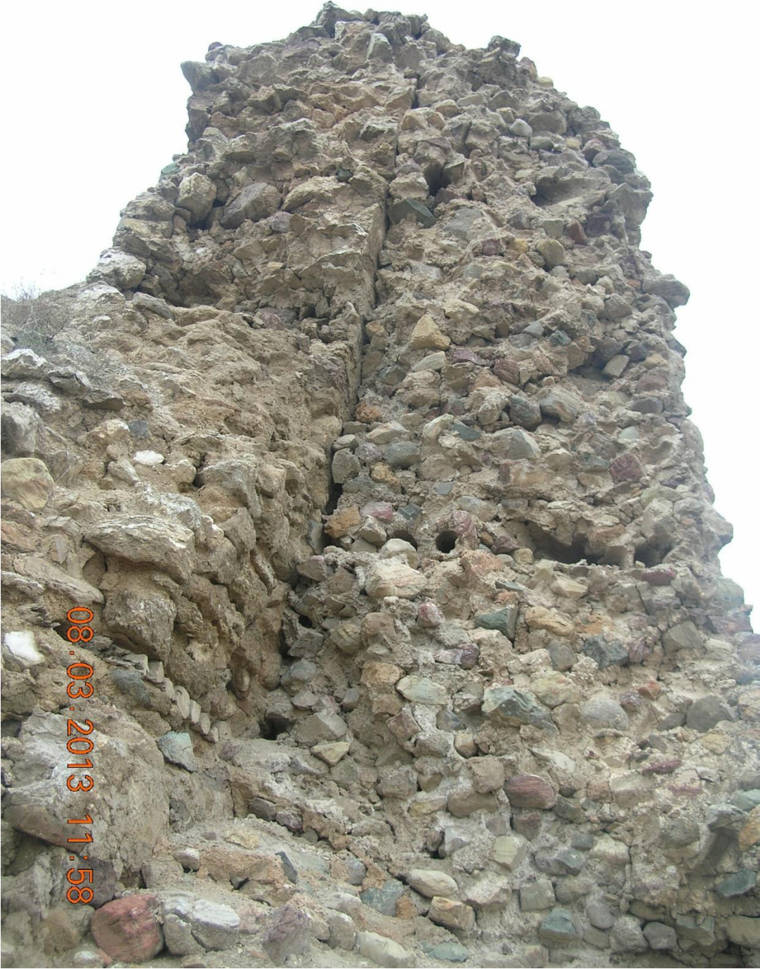
Görsel 3. Çankırı Kalesi'nin Doğal Afetler Neticesinde Tahrip Olmuş Sur Duvarları, Duvarlar İşlenmemiş Taşlardan Örülmüştür.
