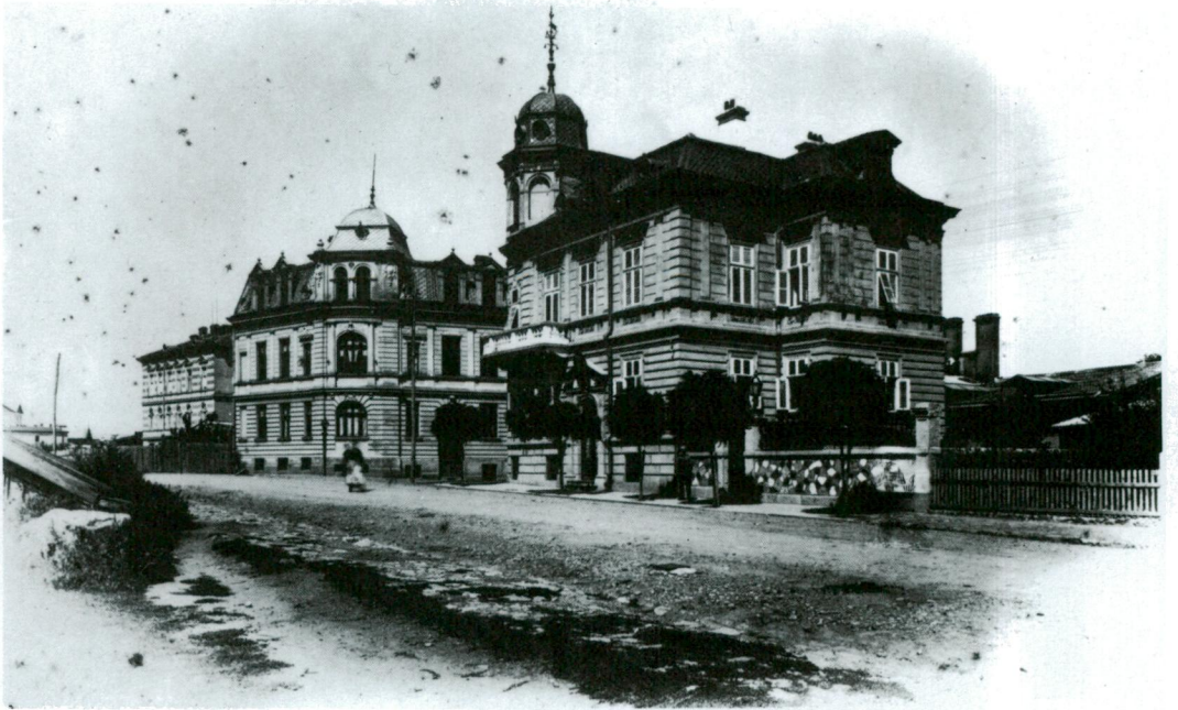
Res. 4 - Bulgaristan KomiserliĐi Binası.
