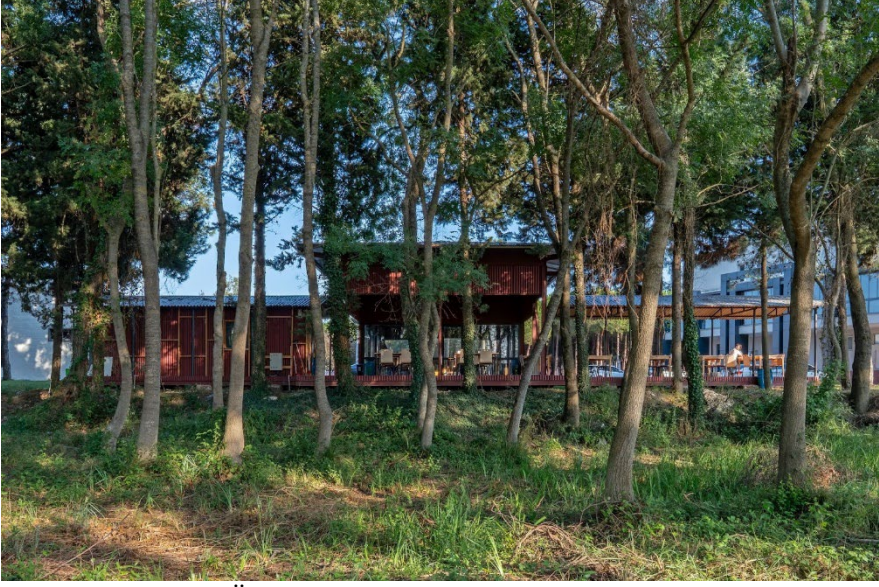
Fotoğraf 12. Samsun Üniversitesi Ballica Kampüsü Kantini Batı Cephesi
