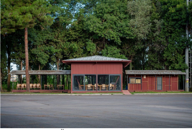
Fotoğraf 11. Samsun Üniversitesi Balıca Kampüsü Kantini Doğu Cephesi
