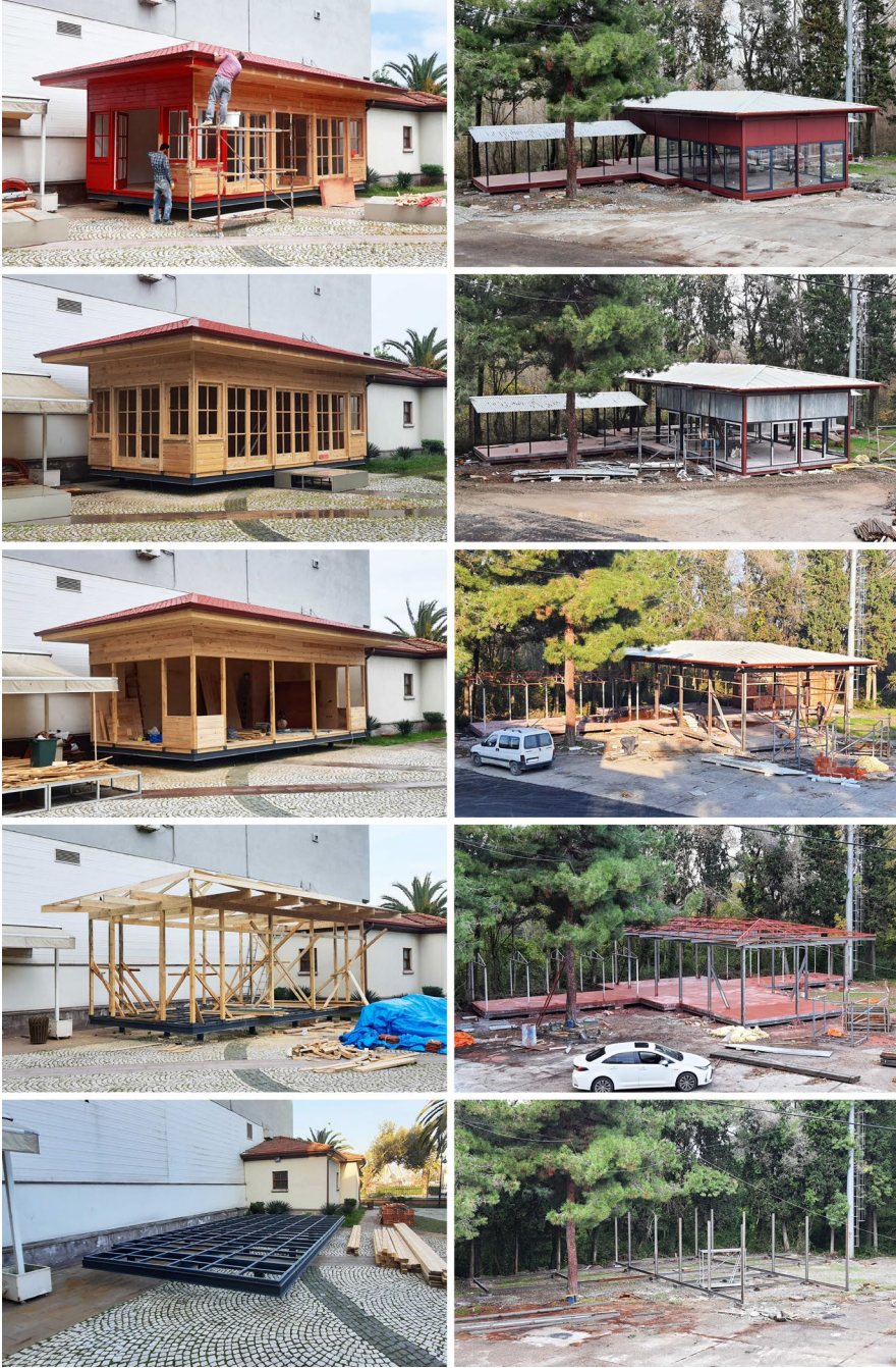
Fotoğraf 17. Samsun Üniversitesi Araştırma Merkezleri Toplantı Salonu ve Balıca Kampüsü Kantini inşa süreçleri
