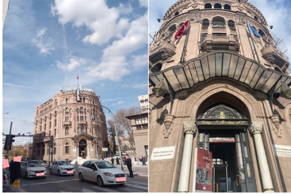
Görsel 7. Paylaşılan yapı odaklı fotoğrafların genel hattı. Sol: Yapının genel kabuğu, Sağ: Yapı kabuğundan detaylar (Yazar tarafından fotoğraflanmıştır).
