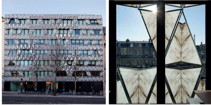
Görüntü 9: Diptech firması dijital baskı cam dış cephe uygulaması, - Barclays Bankası/ Fransa (2011). https://www.dip-tech.com/about/projects/27-projects/171-the-origami-building
