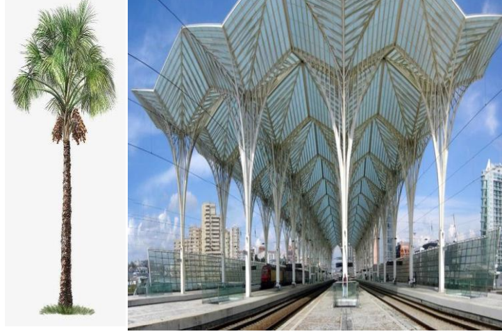
Şekil 18. Oriente İstasyonu Çatı Örtüsü ve Palmiye Formu [31]
