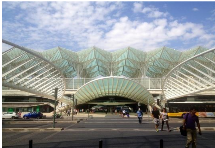
Şekil 19. Oriente İstasyonu Çatı Örtüsü [33]
