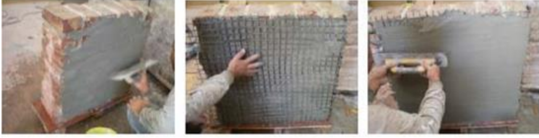
Resim 6. Duvarların TRM ile güçlendirilmesi
