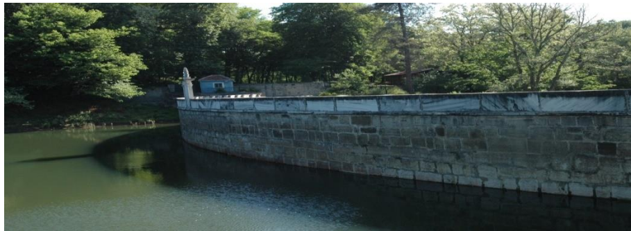
Resim1. Taksim su bendlerinde yapılan çimento içerikli onarımlar
