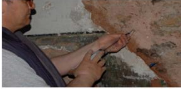
Resim 5. Duvarda mikro enjeksiyon uygulaması
