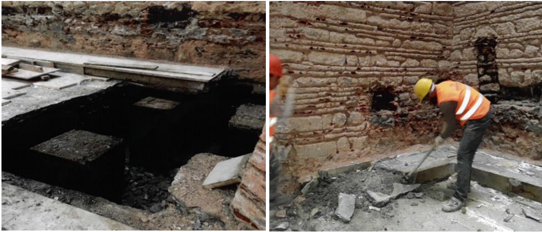
Resim 3. Selimiye Hamamı Restorasyon çalışmaları
