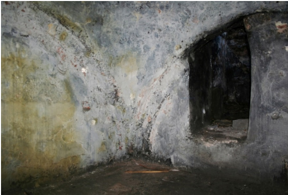
Görsel 19: Kuzey halvete eklenmiş olan ikinci kattan görünüm üstteki kubbeyi duvarlara oturtan pandandif geçişleri görülebiliyor. Ayrıca niş gibi görünen yer bu kata ulaşımı sağlayan geçit. (İstanbul Arkeoloji Müzeleri Kazlıçeşme Hamamı Kazısı Arşivi)
