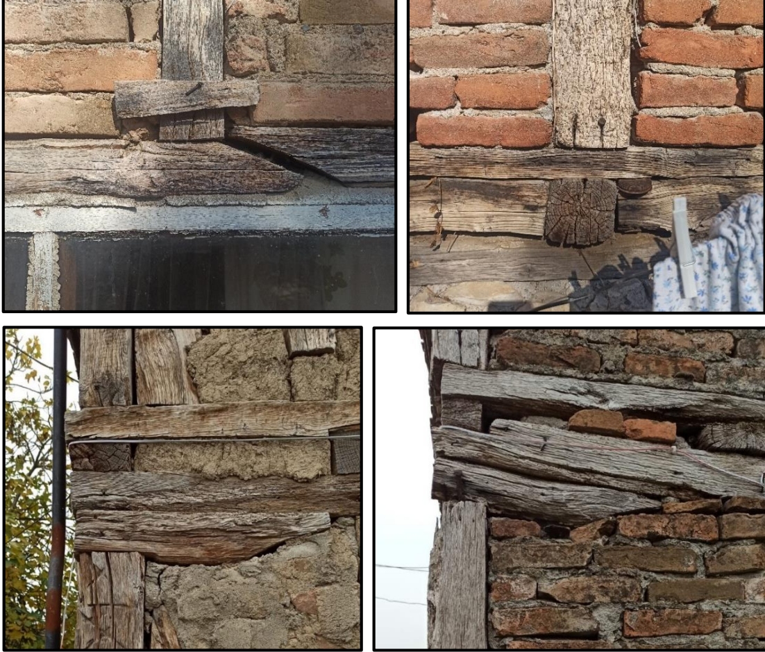
Şekil 10. İncelenen yapılarda bulunan birleşim detay örnekleri [11]
