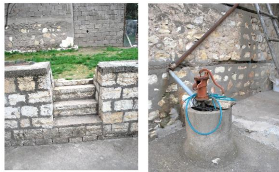
Şekil 7. 6 Şubat 2023 Depremleri Öncesinde Hasan Arıkan Evi Avlusunda Yer Alan Merdiven ve Kuyu (KBB, 2013)
