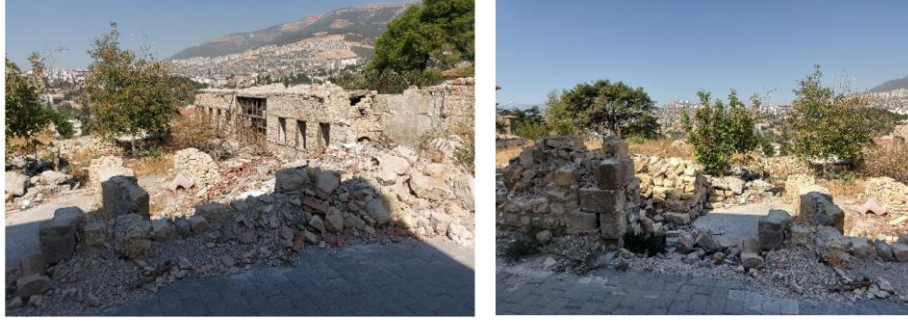
Şekil 9. Hasan Arıkan Evi'nin 6 Şubat Depremleri Sonrasındaki Mekânsal Durumu ve Enkazı (Fotoğraflar, Yazar Tarafından Çekilmiştir)
