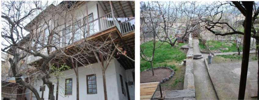
Şekil 5. Hasan Arıkan Evi ve Avlu/Bahçesinin 6 Şubat 2023 Depremleri Öncesindeki Durumu (KBB, 2013)
