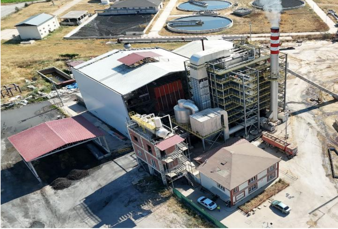
Şekil 1. CEMAK biyokütle enerji santrali
