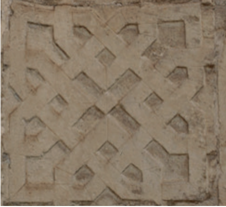
Görsel 7. Divriği Kale Camii Taçkapısı Bordüründeki Süsleme ve Kazıma Tekniği
