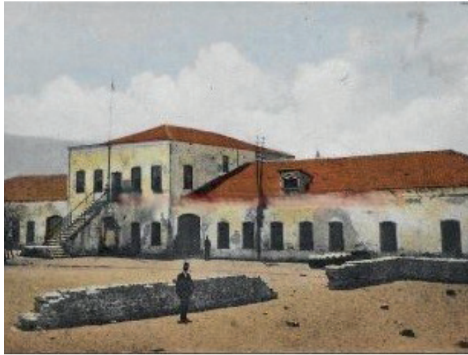
Görsel 8: İskenderun Gümrük Binası'na Ait Tarihsiz Bir Fotoğraf (Tülün, 2021, 84)
