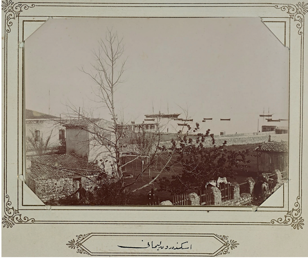
Görsel 11: İskenderun Gümrük Binası Önündeki İskele ve Doğusundaki Karantina Dairesinin Arka Cephesi (İstanbul Üniversitesi Nadir Eserler Kütüphanesi No: 90478/0091)
