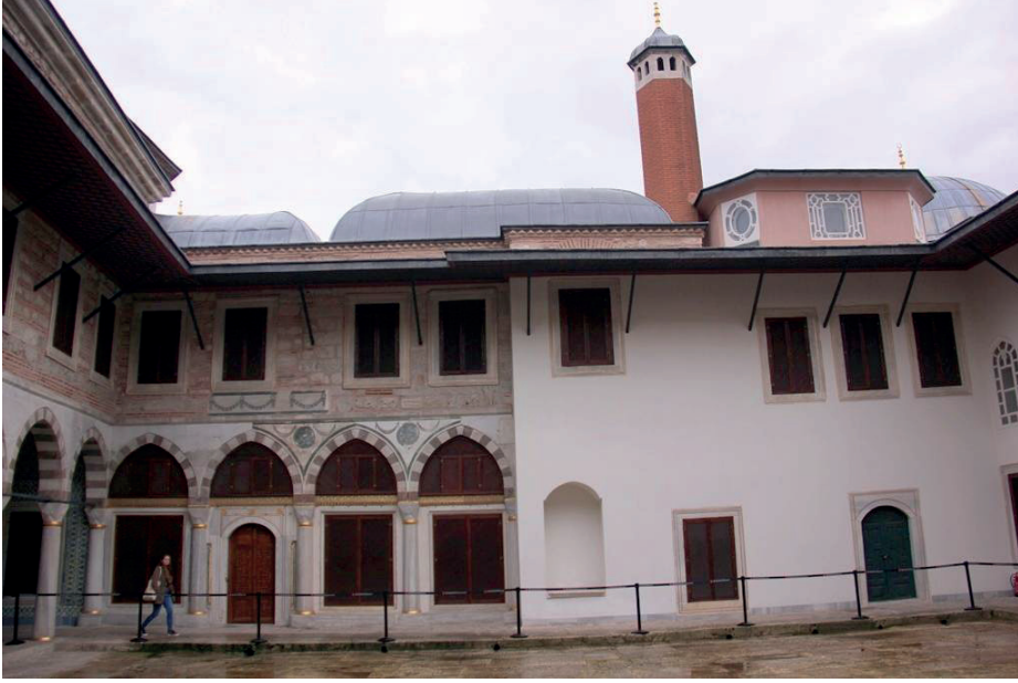
Şekil 15: Vâlîde Giriş Holü Cephesi, Milli Saraylar Fotoğraf Arşivi.
