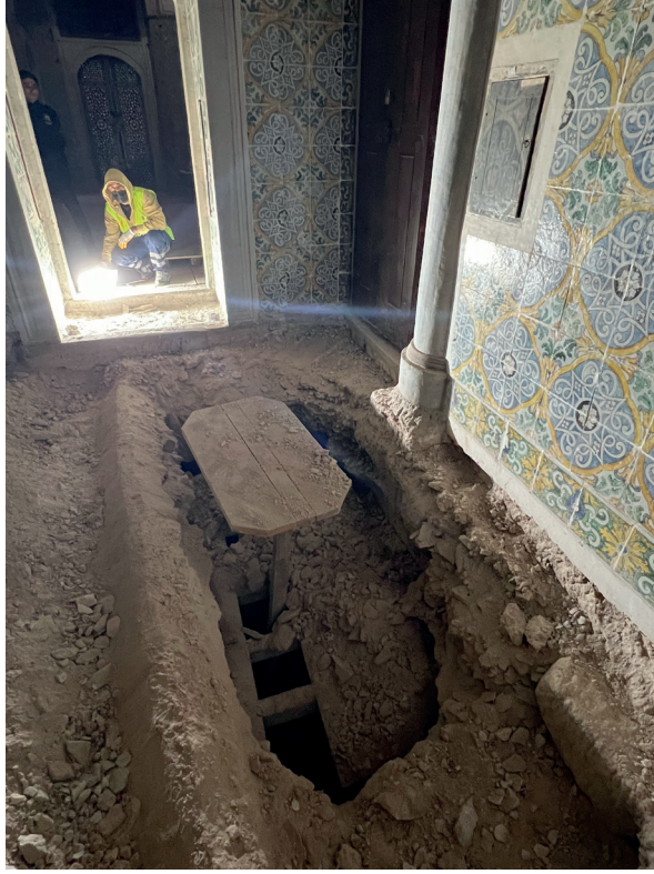
Şekil 21: Vâlîde Giriş Holü Zemindeki Göçmeler (2025), Milli Saraylar Fotoğraf Arşivi
