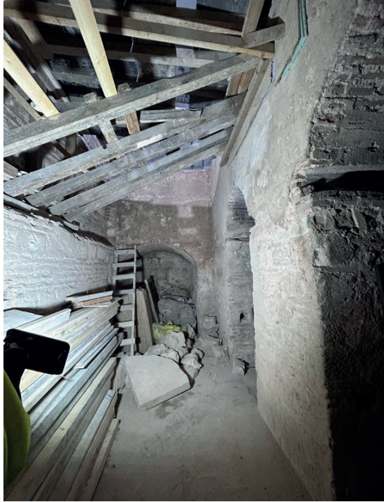
Şekil 24: Vâlîde Giriş Holü Altındaki Mekan ve Taşlık Cephesine Doğru Uzanan Merdivenler (2025), Milli Saraylar Fotoğraf Arşivi
