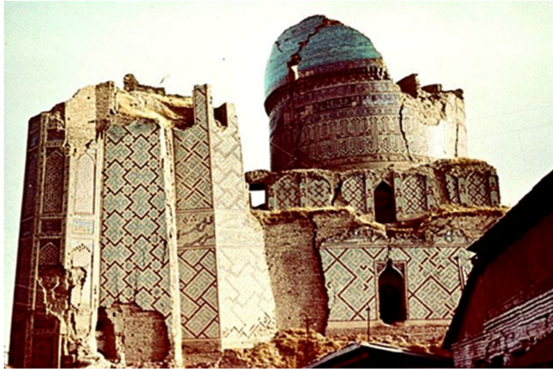
řekil 4. Bibi Hanım Camii restorasyon öncesi durumu [17].
