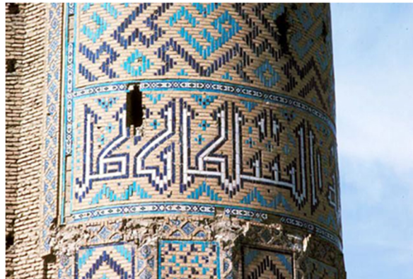
Şekil 2. Portal kulesinden bezeme detayı [12].
