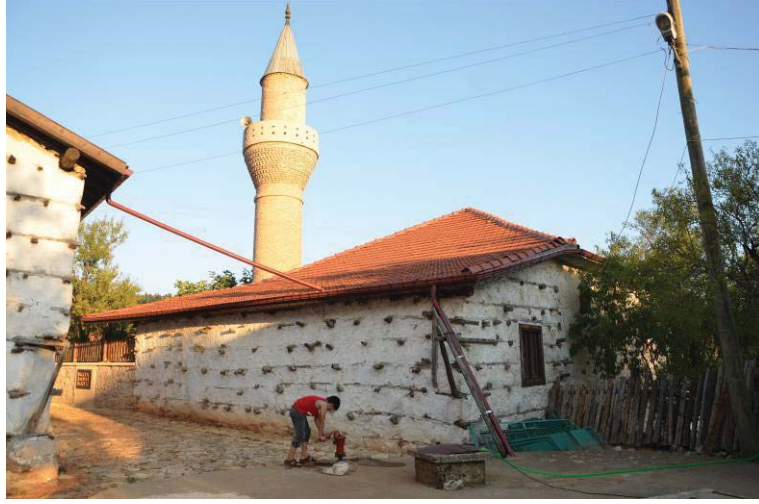
Görsel 3: Caminin kuzey cephesi
