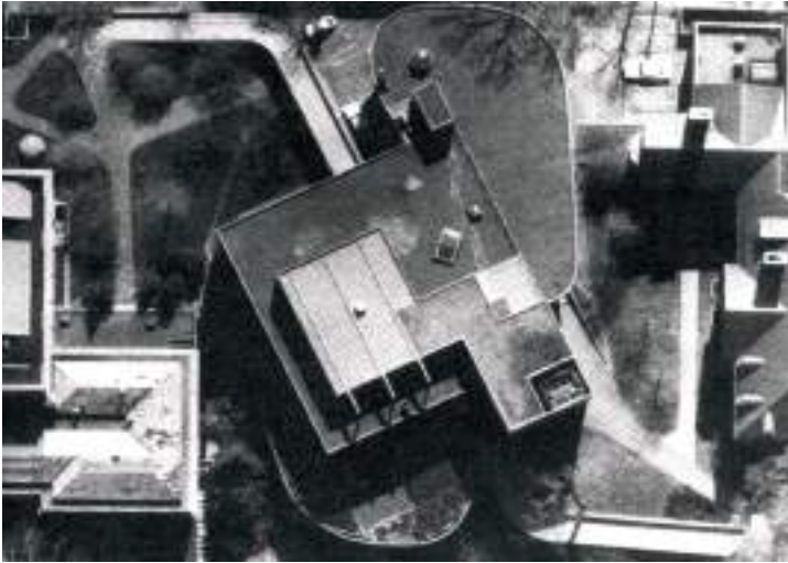
Görsel 4. Le Corbusier, 1961-1964, Carpenter Görsel Sanatlar Merkezi. Fondation Le Corbusier. Erişim: 24.09.2015. http://www.fondationlecorbusier.fr
