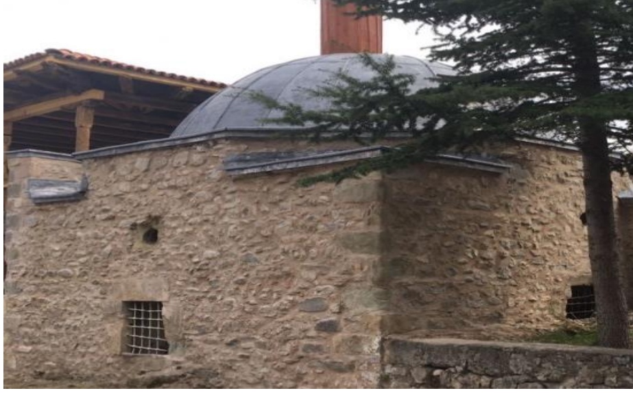
Fotoğraf 4. Hatice Hanım Türbesi'nin Kuzeybatı Cephesi (27.03. 2017)
