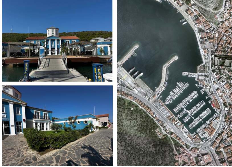
Şekil 1. Çeşme Marina Yönetim Binası (Sol üst ve alt görsel, Kaynak: Yazar); Yaz Okulu Proje Alanı (Sağ görsel, URL1)
