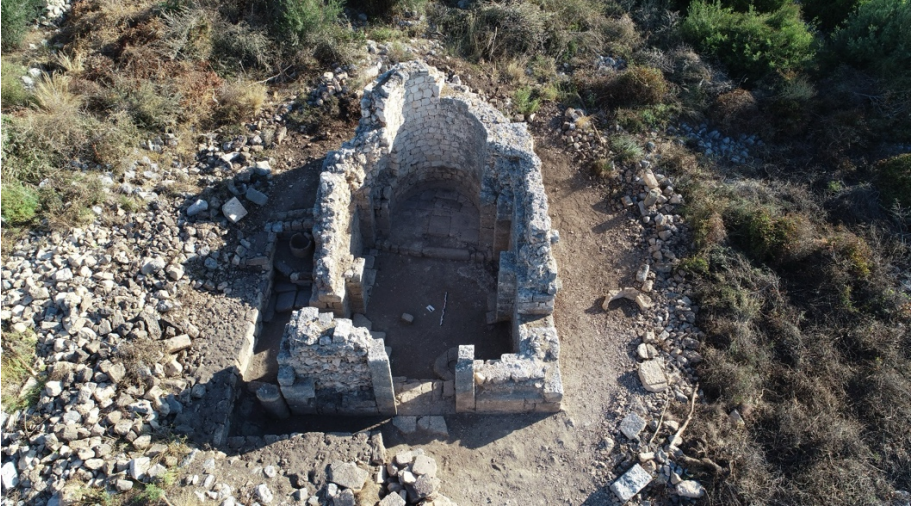
Fotoğraf 1: Korykos Kalesi Şapeli, Genel Görünüş (Korykos Kalesi Kazı Arşivi).
