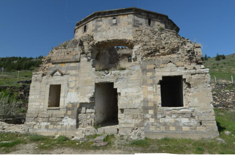
Görsel 5. Nevşehir Rum Hamamı, Soyunmalığın Doğu Cephesi.
