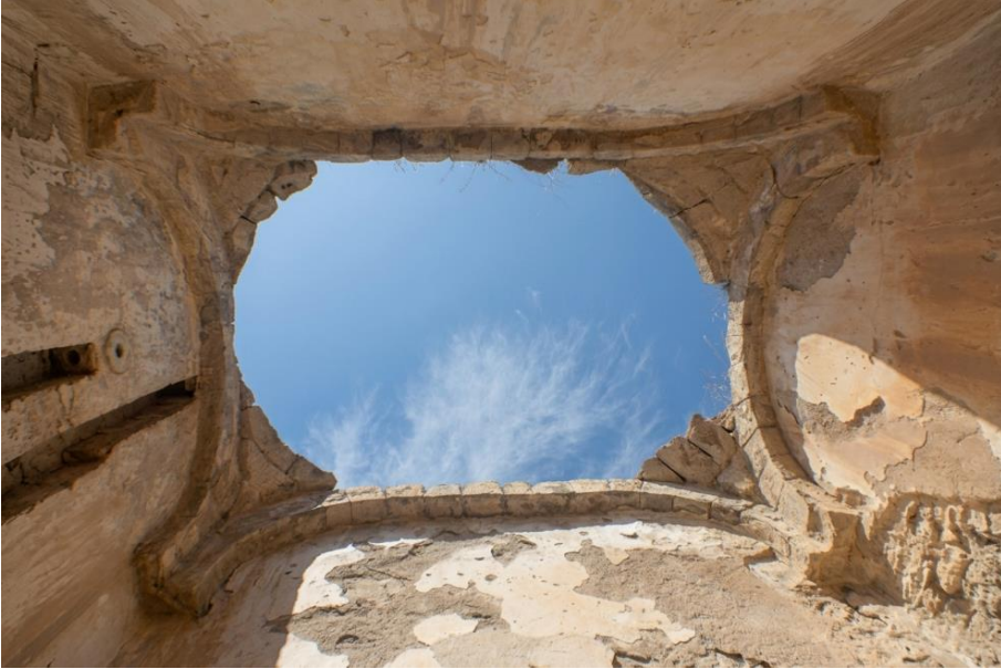
Görsel 9. Nevşehir Rum Hamamı, Güneydeki Halvetin Üst Örtüsü.
