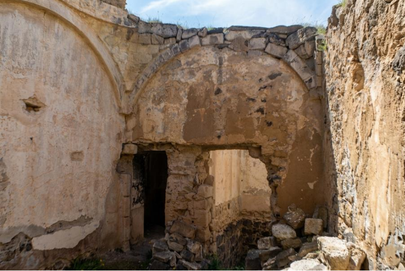
Görsel 8. Nevşehir Rum Hamamı, ılıklik Bölümü, Güneydeki Halvet ve Tuvalet Girişleri.
