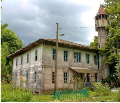
Şekil 1. Alan Köyü Camii doğu ve kuzey (ön cephe) cephe görünümü
