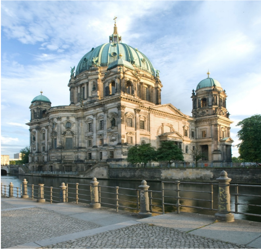
Şekil 9. Berlin Katedrali'nin kuzeydoğu cephesinden görünüş, 2010 (Goralczyk & Hoth, 2001).
