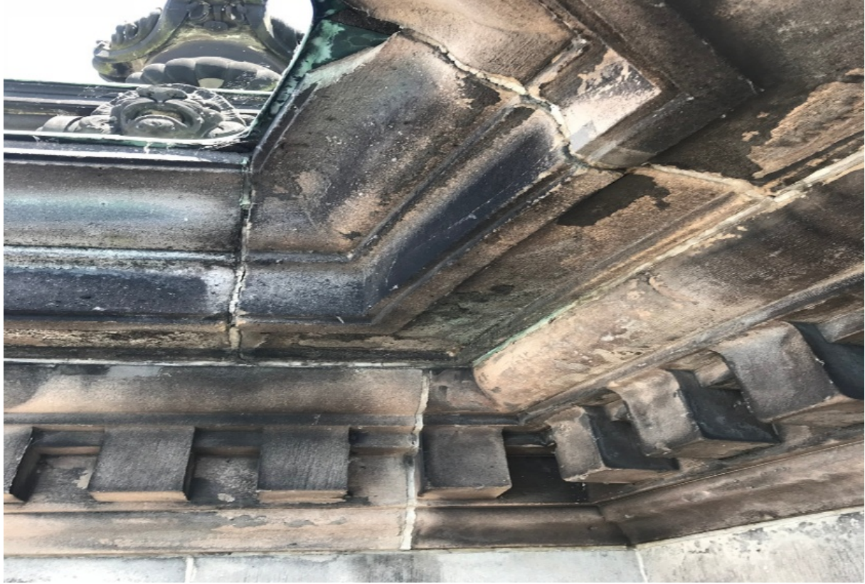
Şekil 14. Restorasyon süreci, Bozuk derzler ve yüzeyler (Goralczyk & Hoth, 2001).
