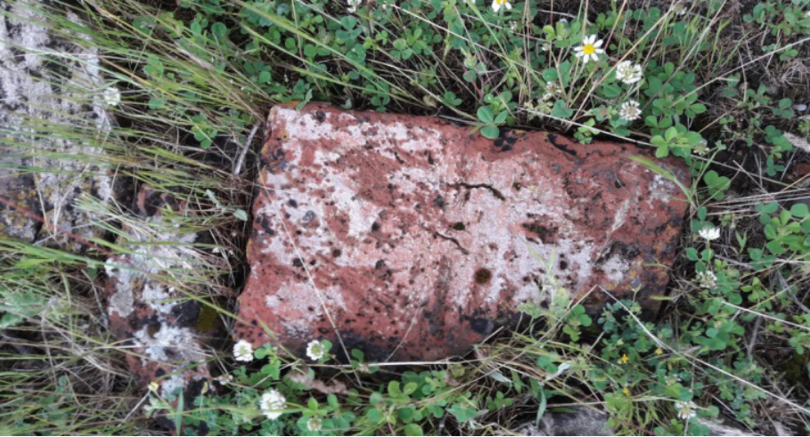
Foto 9: Kalede Kaplama Olarak Kullanılan Tuğla Malzeme
