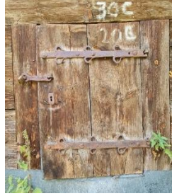
Şekil 2. Kapı Genel Görünüş.
