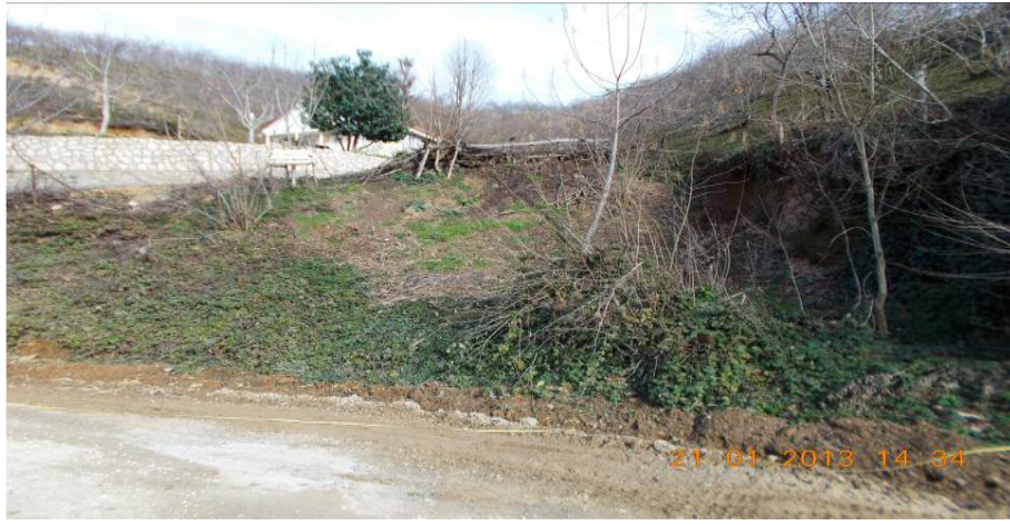
Şekil 15. 7 nolu dolu dere yolunun dolgu zeminle kapatılması 1 nolu heyelanın üst kesimi
