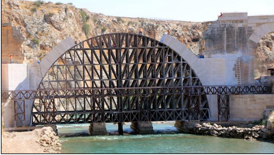
Şekil 5. Kızılın Köprüsüne Ait Restorasyon Çalışması (Milliyet, 2025).
