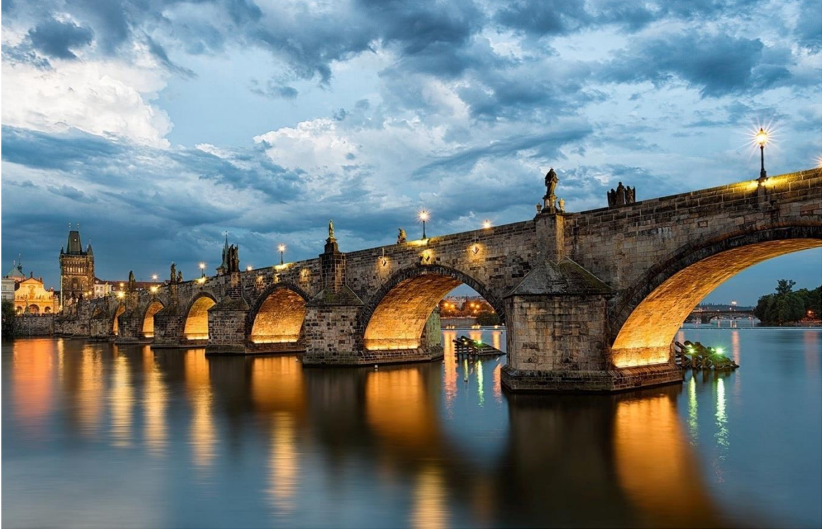
Şekil 10. Restore Edilmiş Karl Köprüsü (Wallpaper Flare, 2025).
