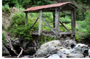
Foto. 25. Baltacılar Köprüsü mansab yüzü - güneyden
