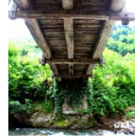
Foto. 6. Malakmiyet Köprüsü tabliye altı - güneybatı yaka
