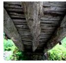
Foto. 28. Baltacılar Köprüsü tabliye altı
