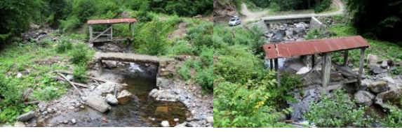
Foto. 21. Baltacılar Köprüsü kuzeydoğu (mansab) cephesi
