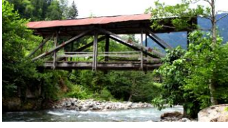
Foto. 2. Malakmiyet Köprüsü güneydoğu (menba) yüzü
