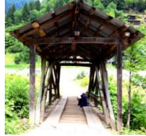
Foto. 5. Malakmiyet Köprüsü güneybatı girişi
