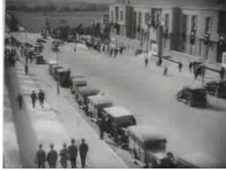
Fotoğraf-6: İstasyon Caddesi, Sayıştay Binası.
