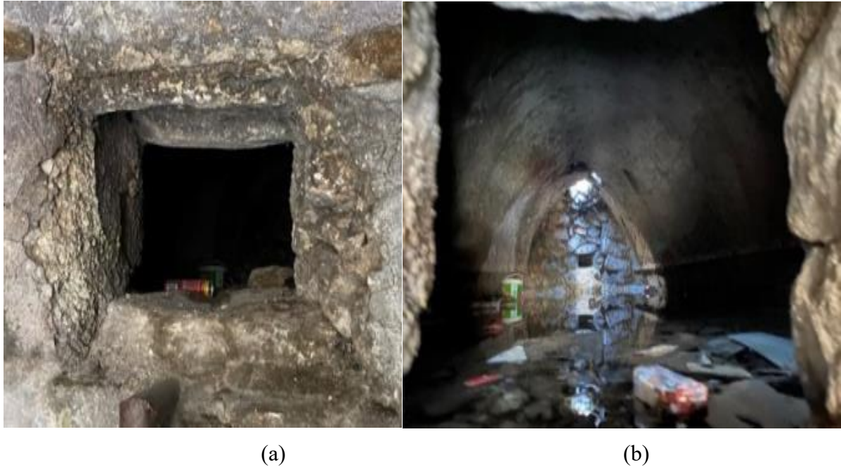
Fig. 7: Ayn Salīb Çeşmesi Hazne İç Mekân Görünüşleri (Kaynak: Öztürk 2021).
