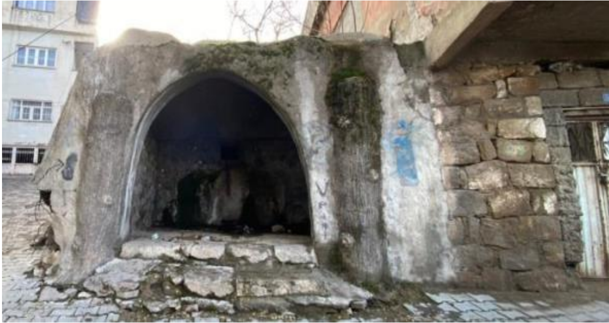
Fig. 9: Ayn Salib Çeşmesi Kuzey Görünüşü (Kaynak: Öztürk 2021).
