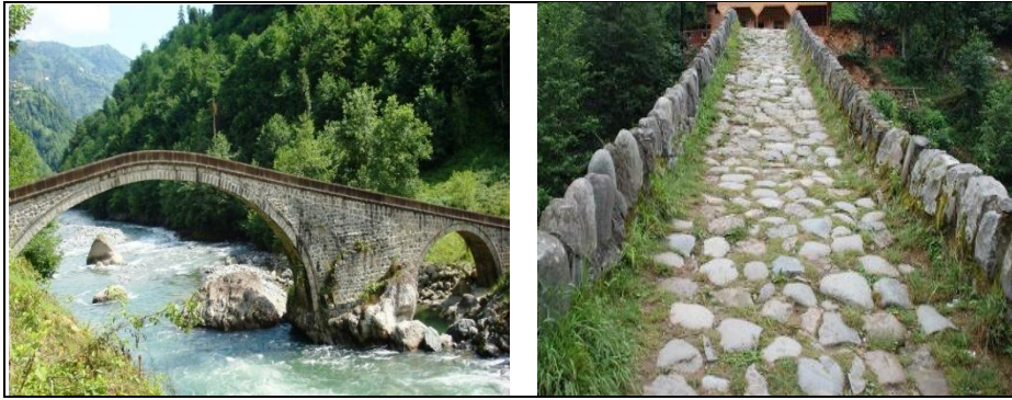
Şekil 1. Timisvat köprüsü (Timisvat bridge) [16]
