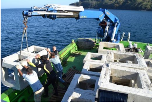
Şekil 10. Beton blokların denize atılması
