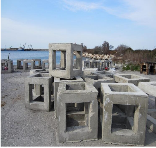
Şekil 4. Transfer yapılacak limana istiflenmiş beton bloklar
