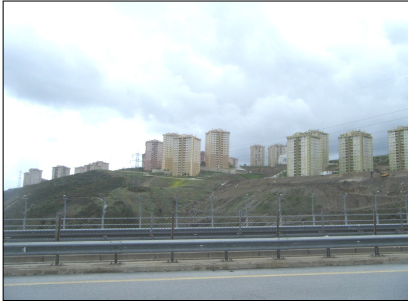
Şekil 6: Uzundere Toplu Konut Alanından bir görünüm Figure 6: A view from Uzundere mass housing area
