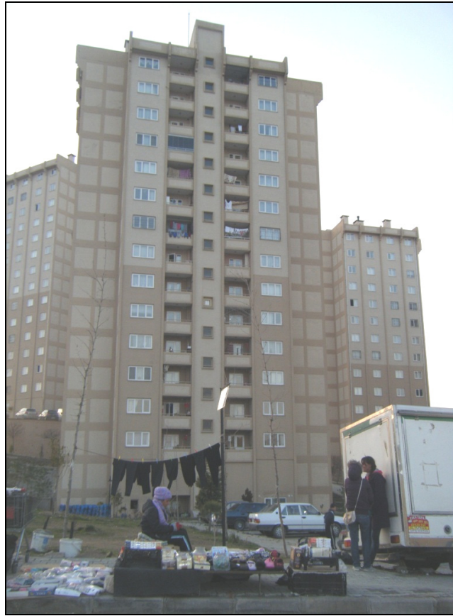
Şekil 7: Gecekondu yaşam tarzının toplu konuta yansması Figure 7: Reflection of slum life style to mass housing
