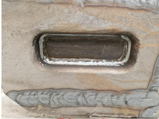
Şekil 4: Üretimde şasinin slot kaynak bölgesindeki paslanma nedeniyle kaynak işleminin yapılamaması.
