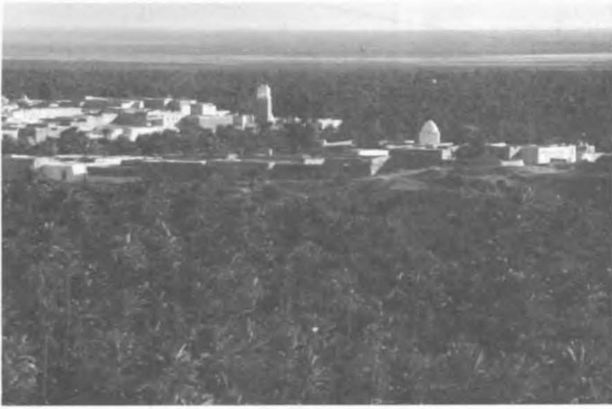
FOTO 1: Tunus gneyinde Őot Cerid kenarındaki bir palmiye-hurma vahası ve Nefta yerleşmesi.
