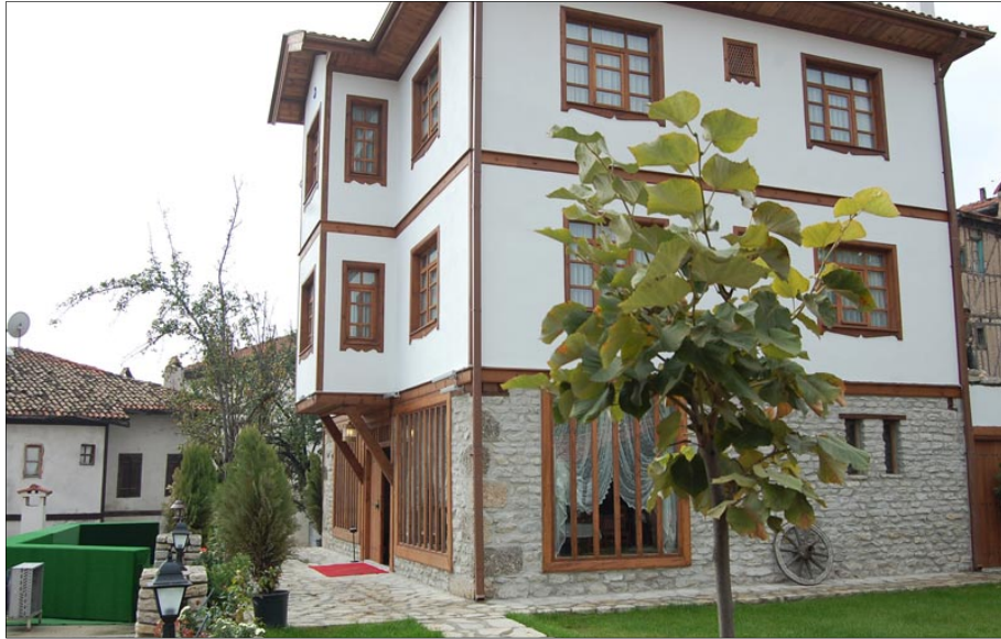
Fotoğraf 10. Safranbolu’da Turizm Amaçlı Kullanılan Geleneksel Bir Yapı (Değişmiş Gliste Özellikleri) Photo 10. A Traditional Structure Used for Tourism in Safranbolu (Modified Gliste Features)
