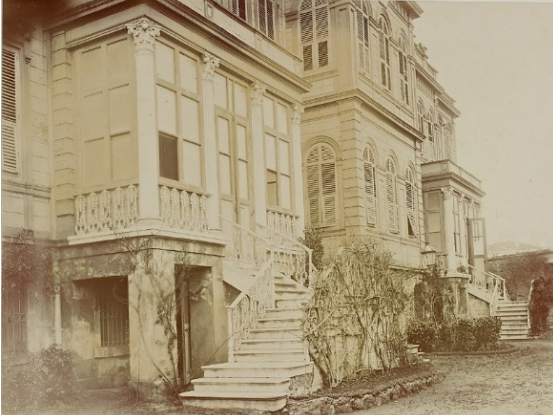
9 Kıbrıslı Mehmed Kâmil Paşa Konağı genel görünüm ve dış merdivenler (İ.Ü. Nadir Eserler Kütüphanesi 90646/6)
