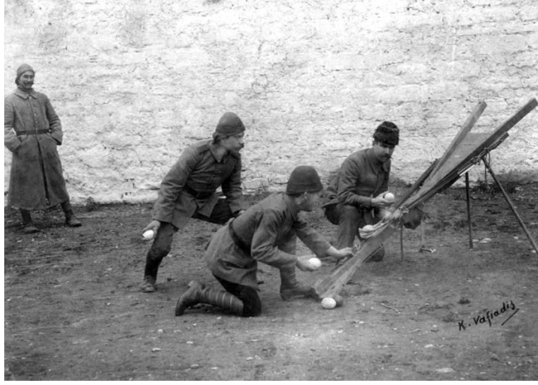
Görsel 4: Tüfenkçiyef El Bombalarını Daba Uzak Mesafeye Atmak İçin Kullanılan Düzenek
