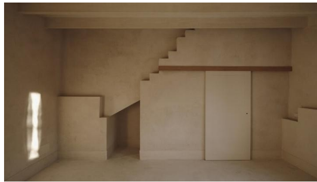
Şekil 10. “Can Monges” projesi kirecin tüm duvarlar, tavan ve zeminde kullanılması [45].
