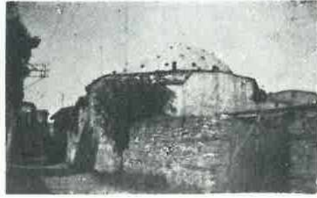
38 — Yadikule Hacı Tahir (Kule) hamamı harabesi, 1931.
