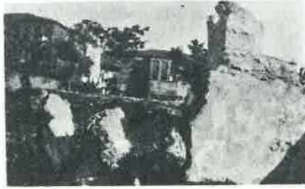
38 — Yedikule Hacı Tahir (Kule) hamamı harabesi, 1931.
