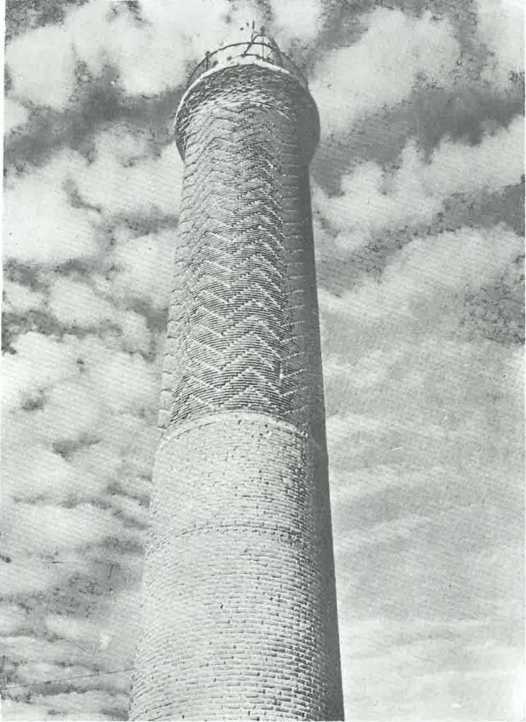
13 — Cacabey Minaresindeki tuğla işçiliğinin yakından görünüşü.
