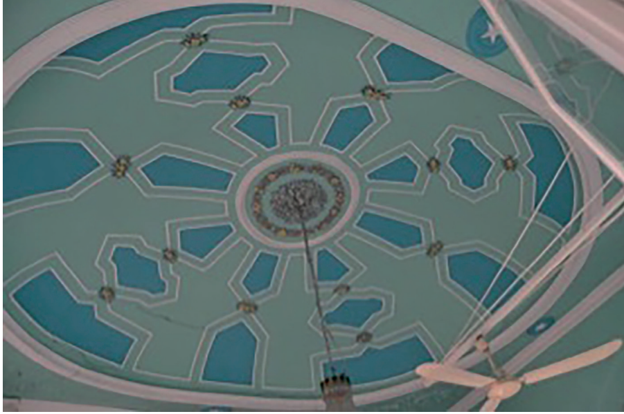
Şekil 20. İzmir Katibzâde Mescidi, harim mekânının üst örtüsü / The superstructure (roofing system) of the prayer hall (harim) of the Katibzâde Masjid, İzmir (M. Yancı, 2026)
